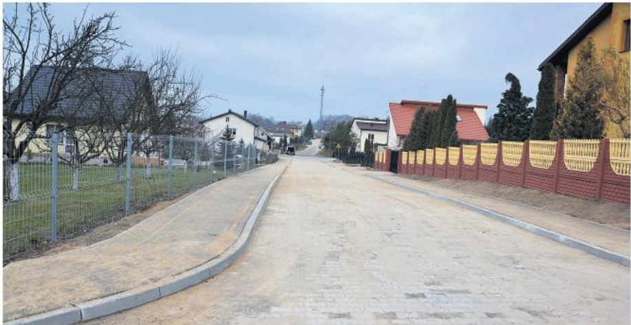
Jedną z ostatnich tegorocznych inwestycji gminnych jest nowa nawierzchnia ulicy Rzemieślniczej w Kikole
