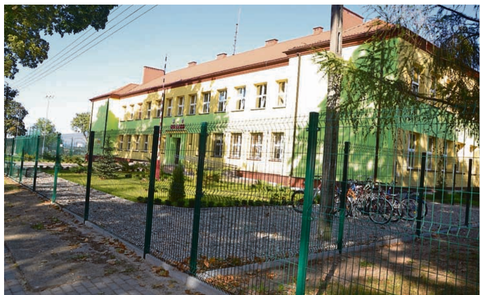
Trwa wymiana ogrodzenia przy Zespole Szkół w Kikole
