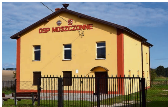
W miejscowości Moszczonne remiza Ochotniczej Straży Pożarnej jest już ocieplona
