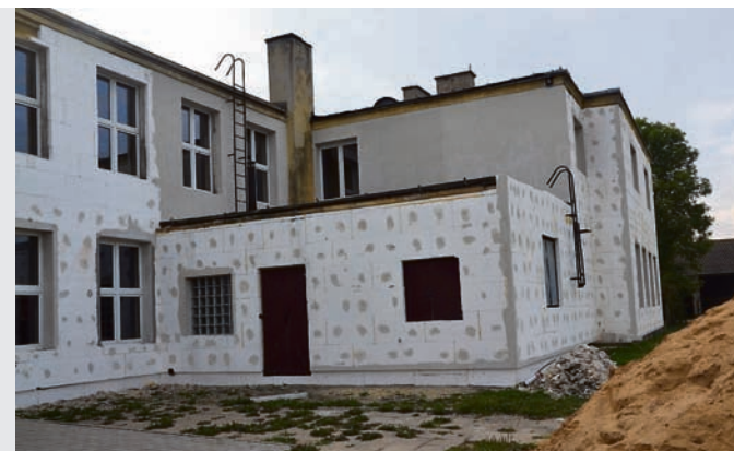
W budynku dawnej szkoły będzie Środowiskowy Dom Samopomocy KONICZYŃKA w Suminie, trwa termomodernizacja obiektu
