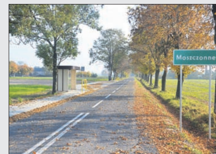
Nowa nawierzchnia drogi w Zajeziórze
