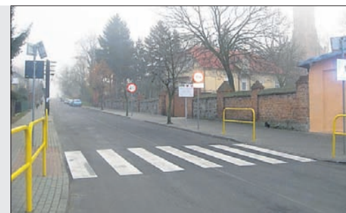
Zmodernizowana droga w miejscowości Wołęcín
