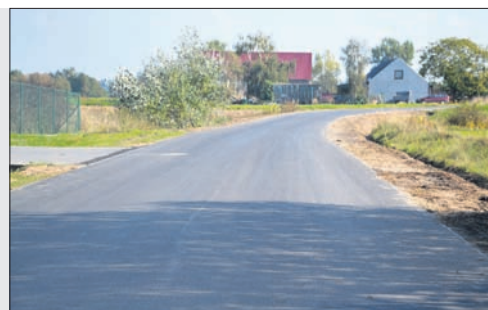
Droga po remoncie w miejscowości Lubin
