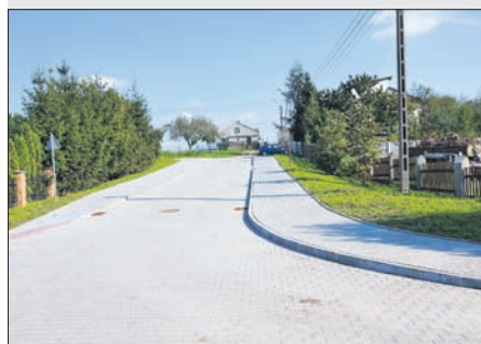
Przebudowana ulica Boczna w Kikole
