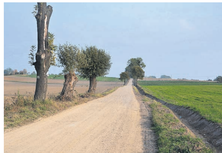
Lubin-Wola po remoncie - z nową nawierzchnią tłuczniową
