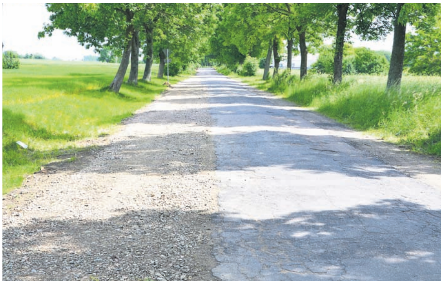
Droga gminna Moszczonno - Zajeziórze przed wykonaniem przebudowy
